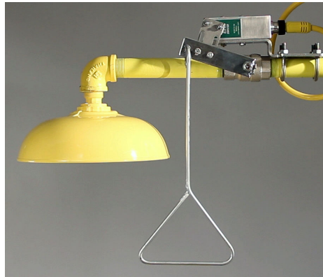
Рисунок 24. Подробный вид установки переключателя в аварийном душе
