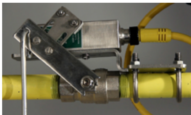
Рис. 7-15. Подробная информация об установке переключателя на аварийный душ
