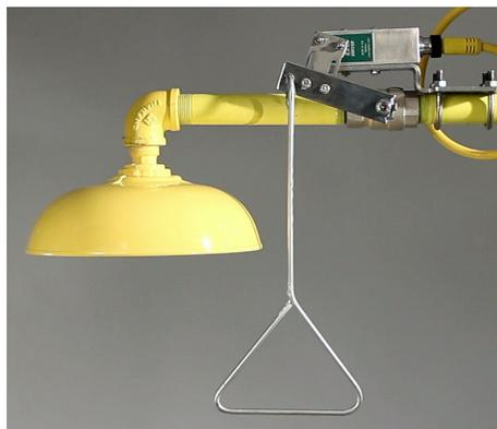
図 24 : 安全シャワーへのスイッチ設置の詳細
