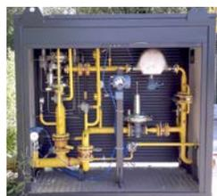
Inyecte GNL regasificado en la red de gas natural con estaciones reductoras de presión y medición.
