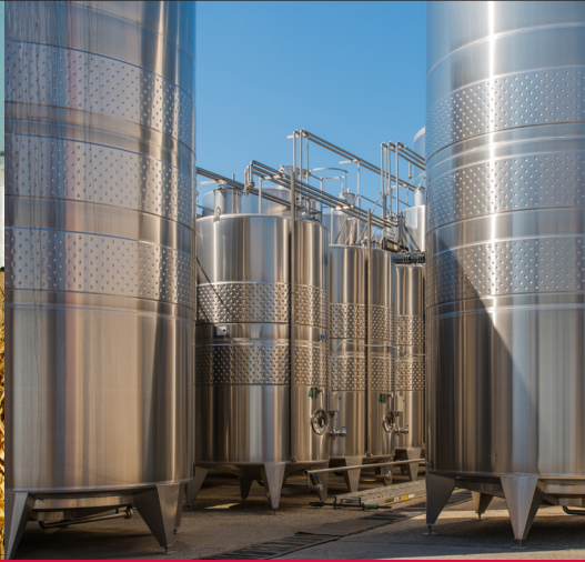
Tanques y terminales
