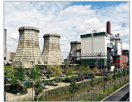
Flingern CHP plant © Stadtwerke Düsseldorf
