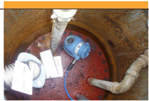
Rosemount 5300 montado em um tanque subterrâneo com espaço vazio e possibilidades de conexão limitadas. A tubulação se estende até o interior dos tanques.
