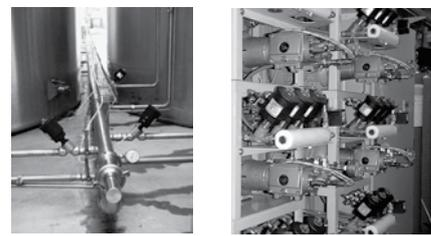
Die Ventilinseln und/oder Pilotventile können an einer Stelle zusammengefasst werden. Möglichkeit des Einbaus im Schaltschrank für den Einsatz in "aggressiven" Umgebungen. Reduzierte elektrische Verdrahtung. Geringe Leistungsaufnahme.
