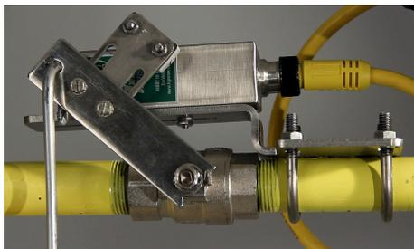
**Figura 25: Válvula do chuveiro de segurança na posição ativada**
