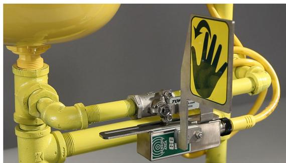
**Figura 27: Lavagem de olhos na posição ativada**
