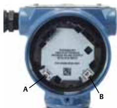
Figura 6. Configurația comutatorului traductorului
