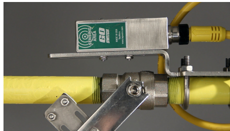
Figura 25: Válvula de ducha de seguridad en posición activada
