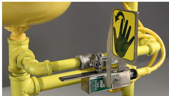
Figura 27: Lavado de ojos en posición activada
