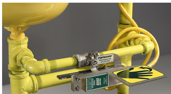
Figura 27: Lavado de ojos en posición activada
