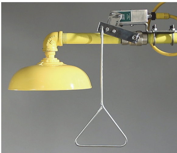
Figur 26. TopWorx-bryter montert på en sikkerhetsdusj
