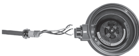
Figura 3-9: Instalación del cuerpo del prensaestopas
