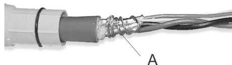
A. Fios de drenagem enrolados em torno da blindagem
