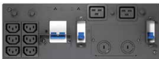
Вид с наружной поверхности
