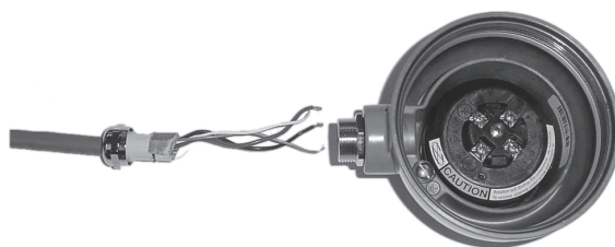
Kuva 3-15: Läpiviennin rungon asentaminen
