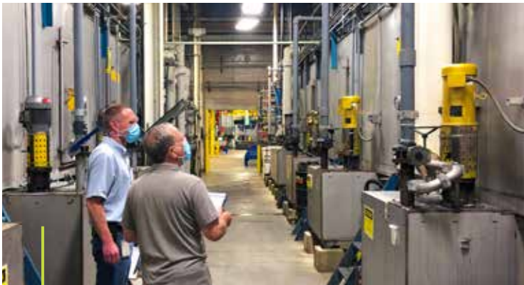
Energy-Treasure-Hunt-Teilnehmer am Produktionsstandort Flow Controls in Marshalltown, Iowa, suchen während eines Durchlaufs außerhalb der Produktionsstunden nach Einsparungsmöglichkeiten.
