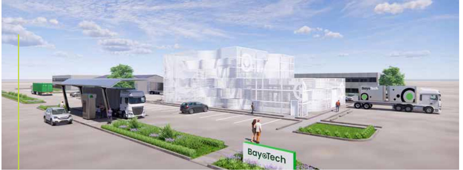
BayoTech의 수소 생성 장치는 미국 전역과 기타 글로벌 위치의 수소 허브 사이트에 설치되고 있습니다.
