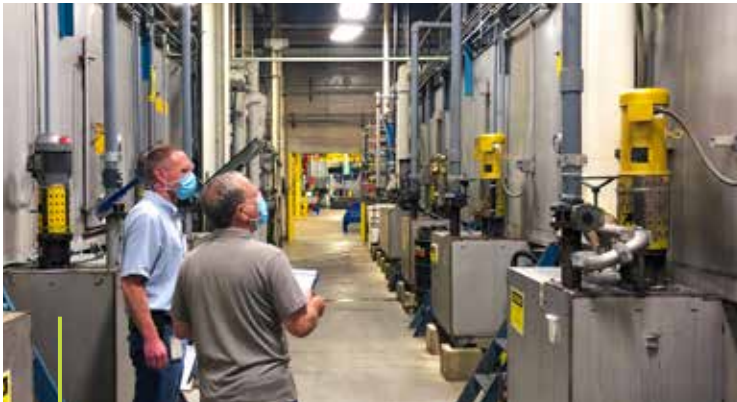
아이오와주 마샬타운에 있는 유량 제어 제조 현장에서 열리는 에너지 보물찾기 참가자들은 비생산 시간 동안 절약 기회를 찾고 있습니다.
